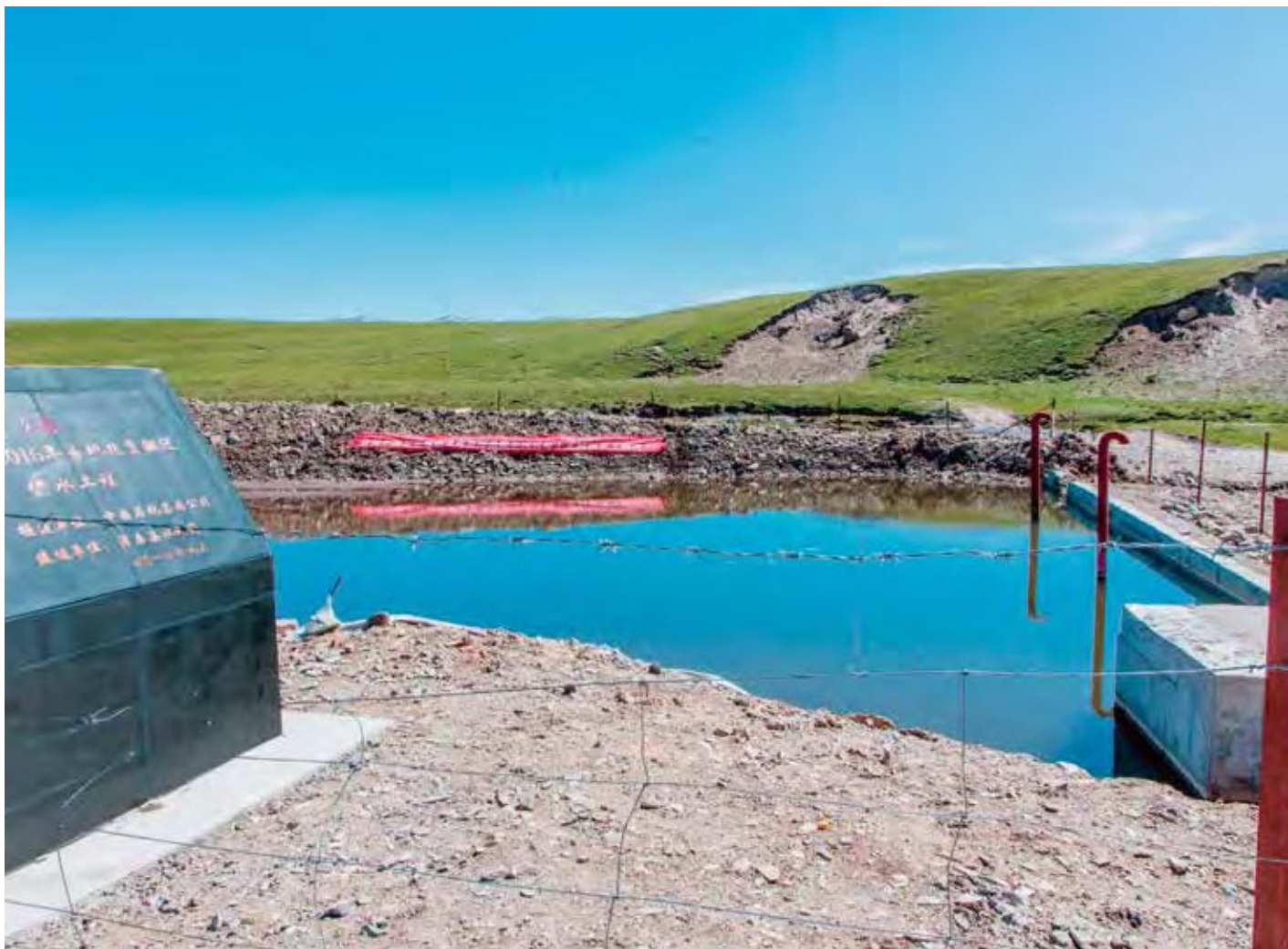
泽库县易地扶贫搬迁供水工程
